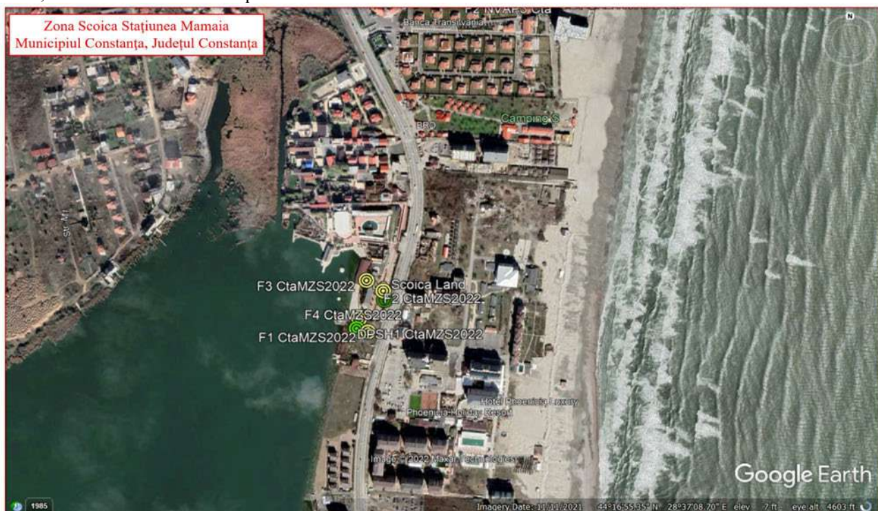
Figura 2. Amplasarea Lucrărilor de Prospectare Geotehnică in Situ Județul Constanța, Stațiunea Mamaia Nord, Zona Scoica Proiect Etapa 1
